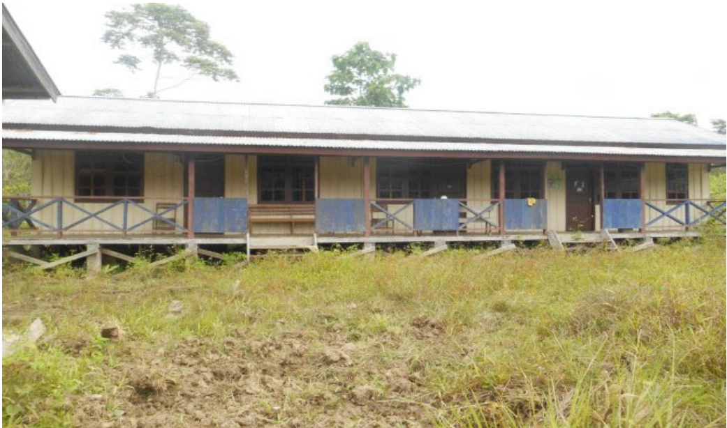
Kondisi Puskesmas pembantu (Pustu) di Kampung Kwarja, kabupaten Jayapura. Foto: Arsip SKPKC Fransiskan Papua
